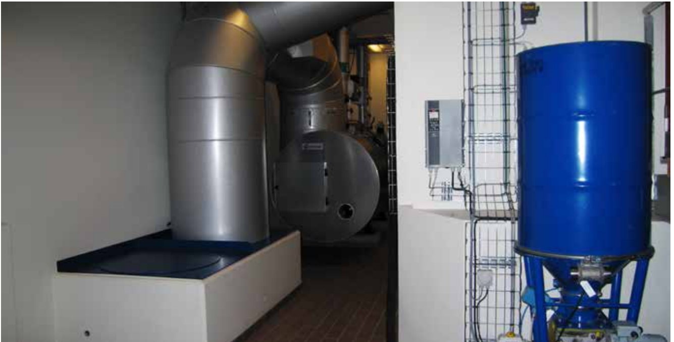
Filterrummet på krematoriet i Svendborg. Her er det Filcon, der har leveret filterinstallationen. Foto: Tommy Christensen.
